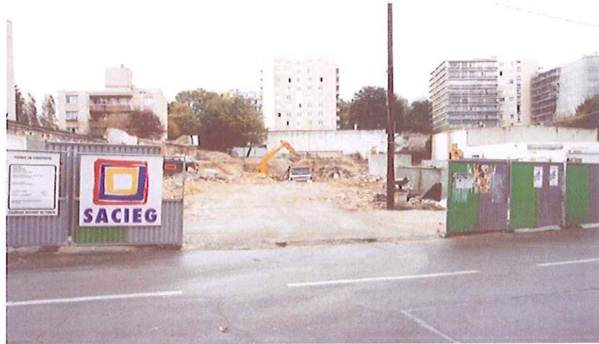
Fig. n°3 : entrée du chantier (rue Jules Vallès)
