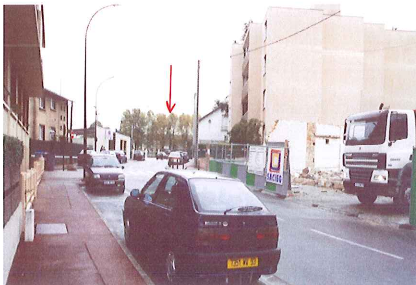
Fig. n°2 : Vue de l'entrée du chantier (rue Jules Vallès) - fléché au fond : le complexe sportif -
