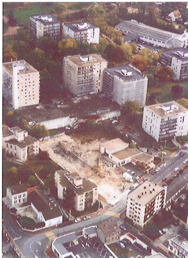
Fig. n°4 : vue aérienne du chantier et de la résidence « CERVETERI »
